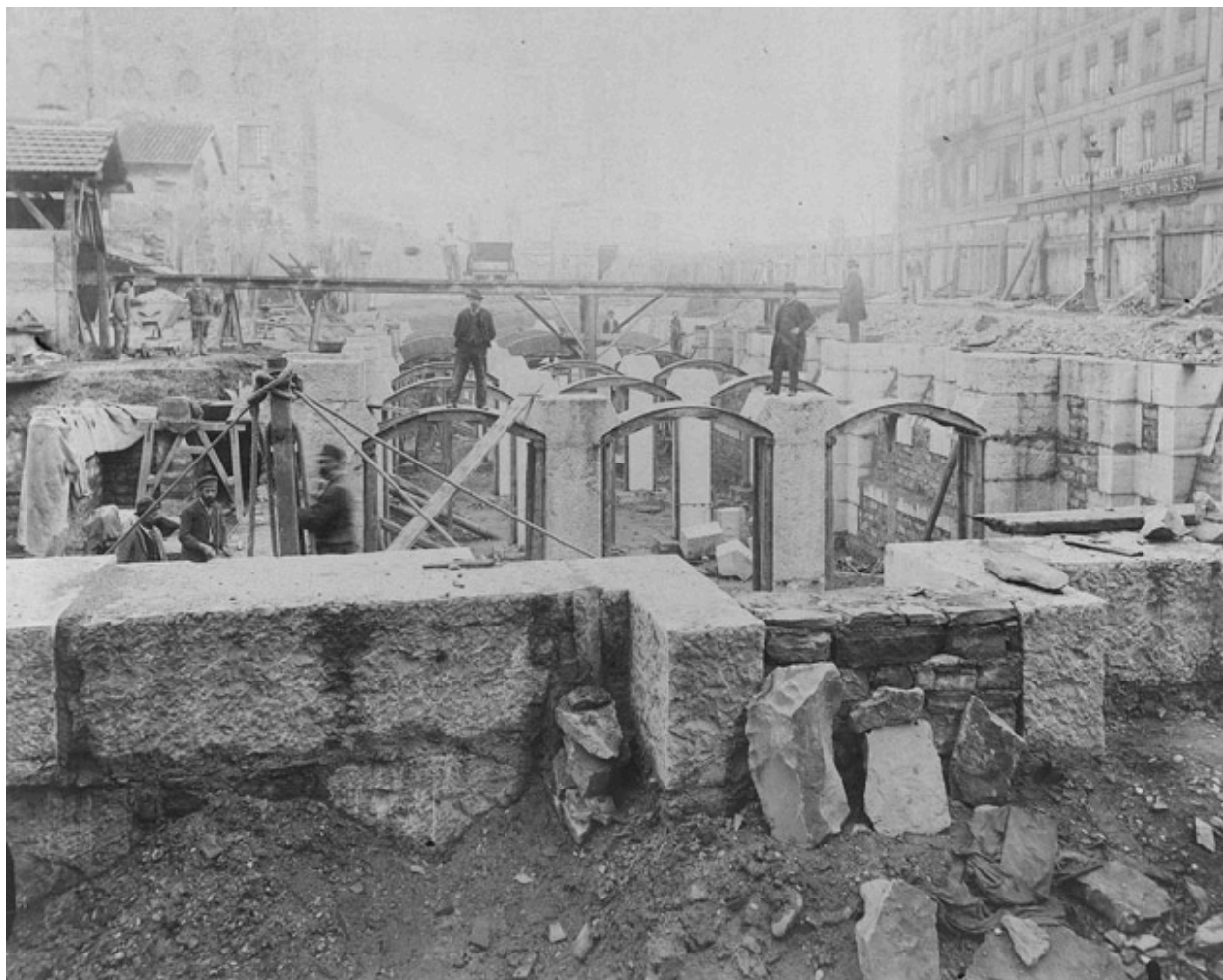
Le bâtiment A' en construction. Photogr., [4e quart XIXe s.] (A. Musée des HCL. AF 37)
