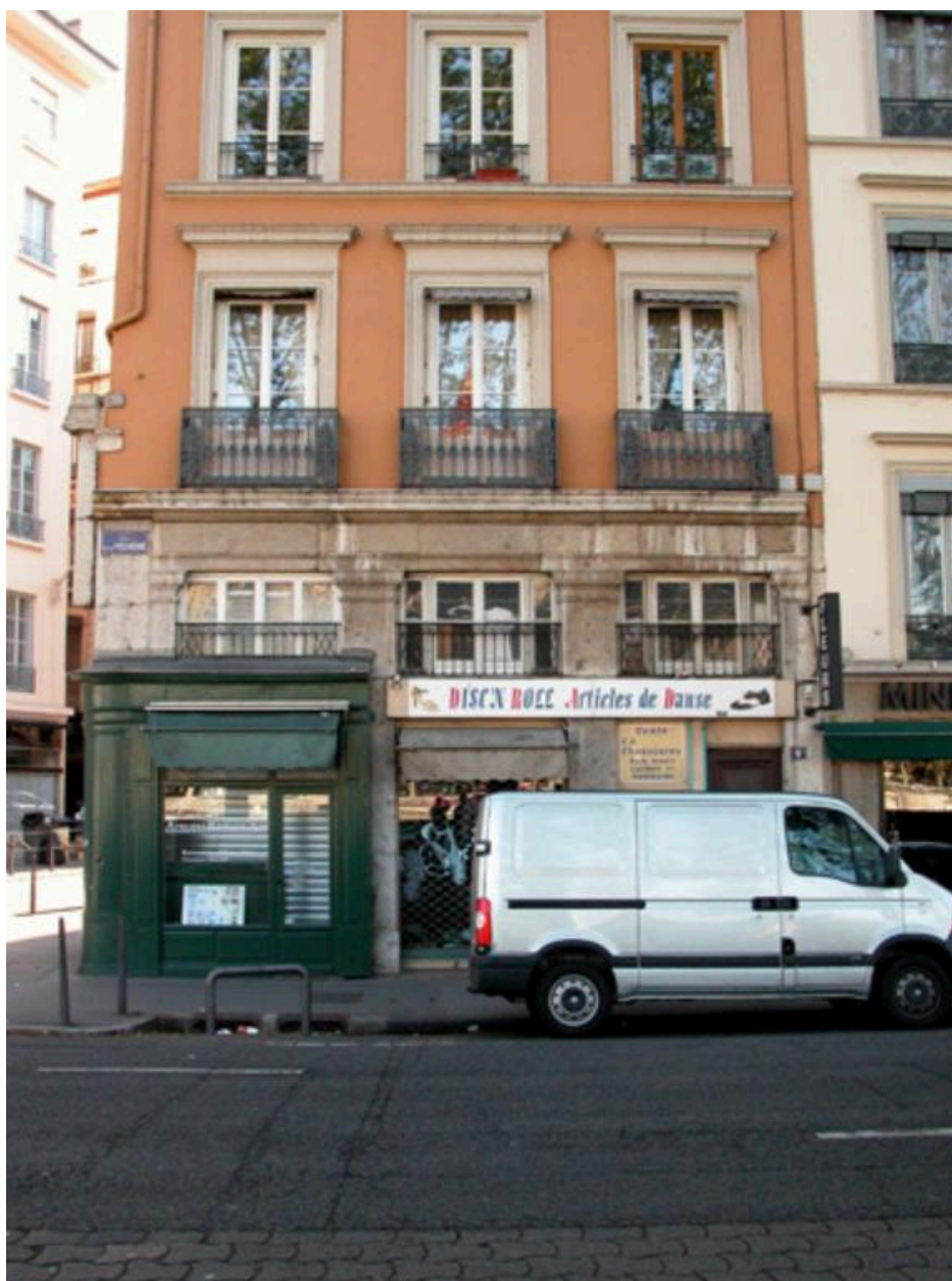
Façade sur le quai, détail des premiers niveaux
