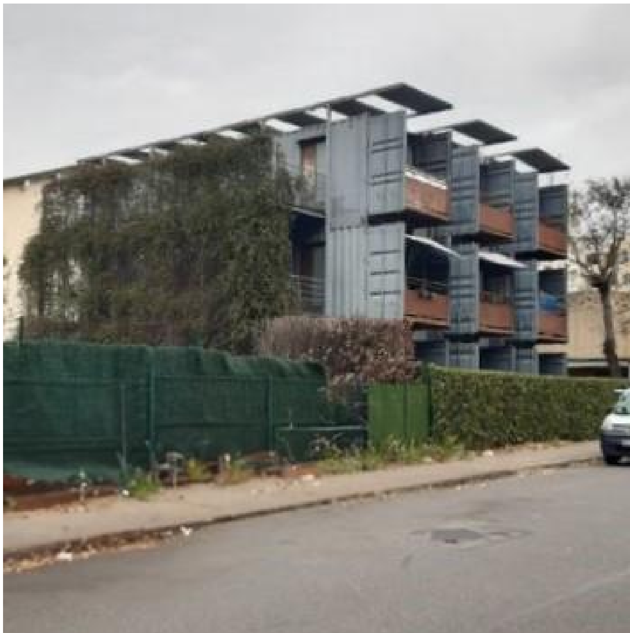
Vue sud-ouest des logements temporaires : containers maritimes
