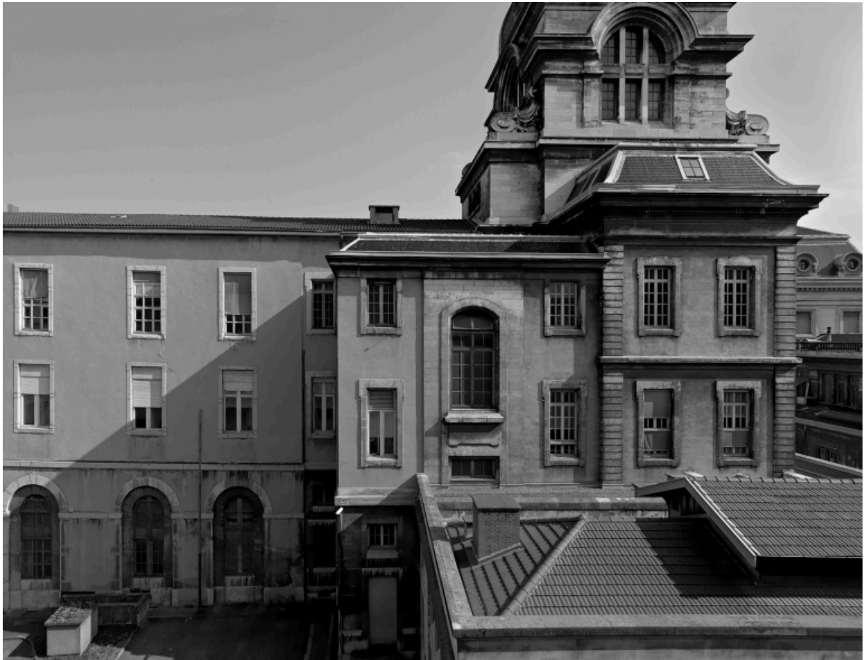
Le dôme Pascalon. Détail de la façade ouest
