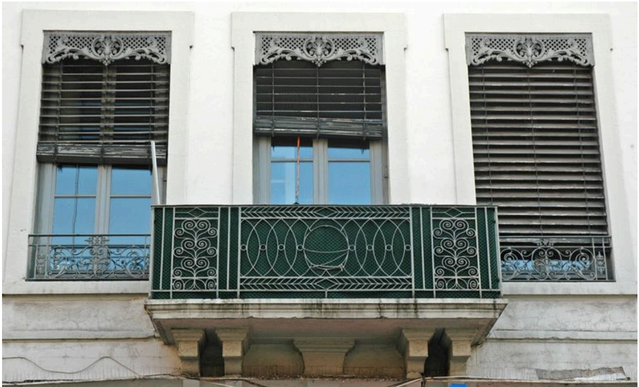
Détail du balcon, grande rue de la Guillotière
