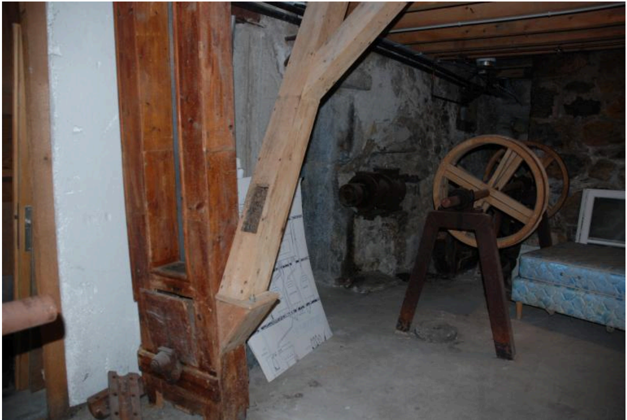
Vue intérieure, étage de soubassement : trémie.
