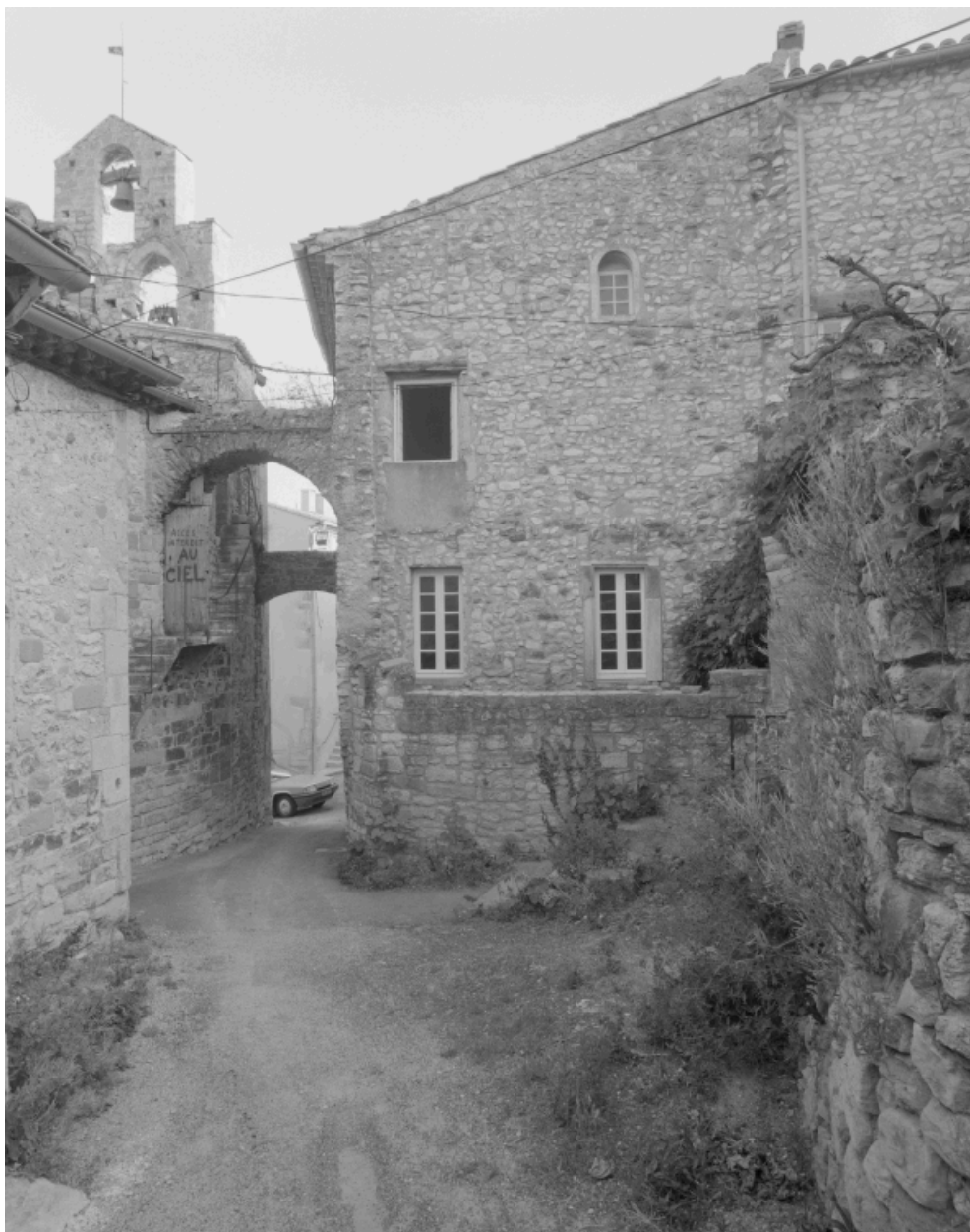
Vue partielle de l'élévation latérale nord-est.
