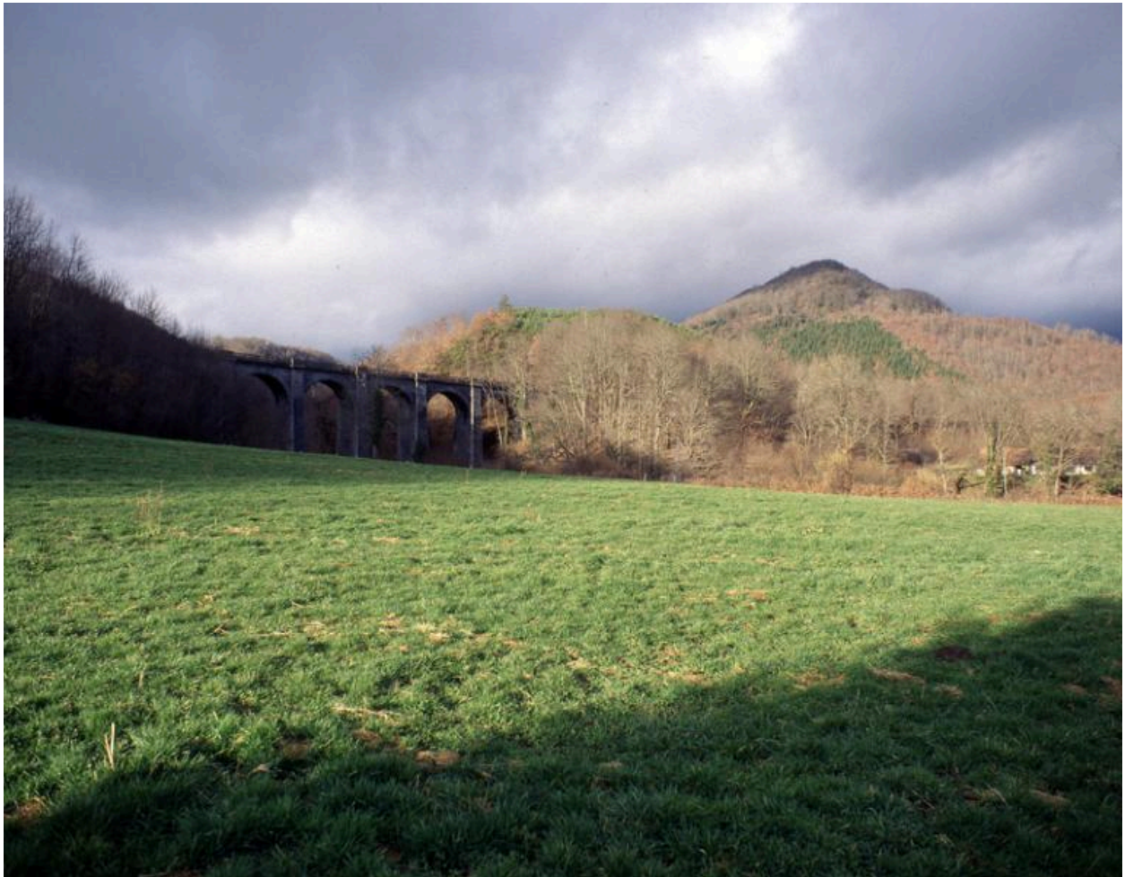
Site du viaduc ferroviaire de Bassignac. A l'arrière-plan, le puy de Frousty.
