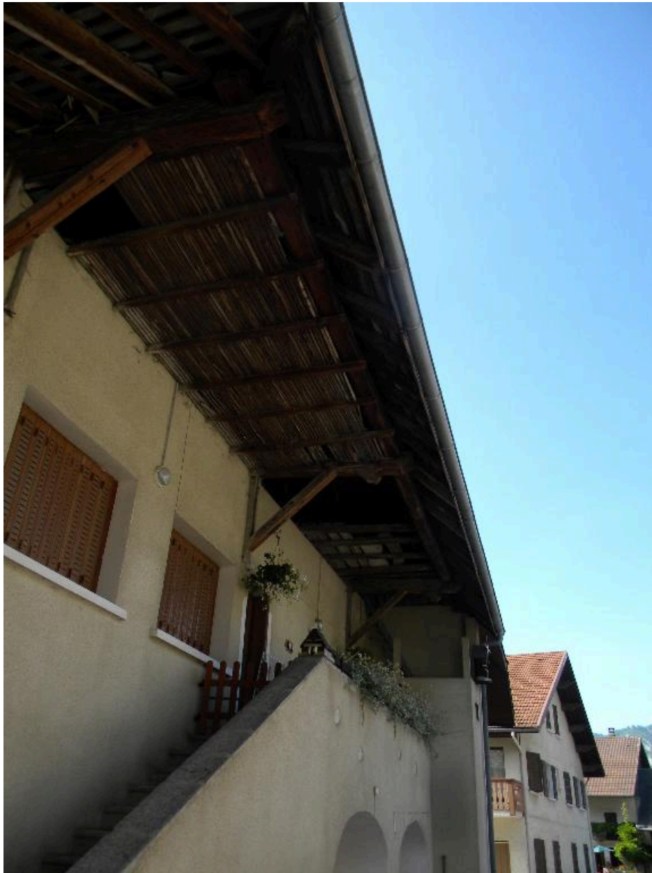
Vue du débord de toiture sur une ferme avec balcon sur double loge (2008 F7 861).
