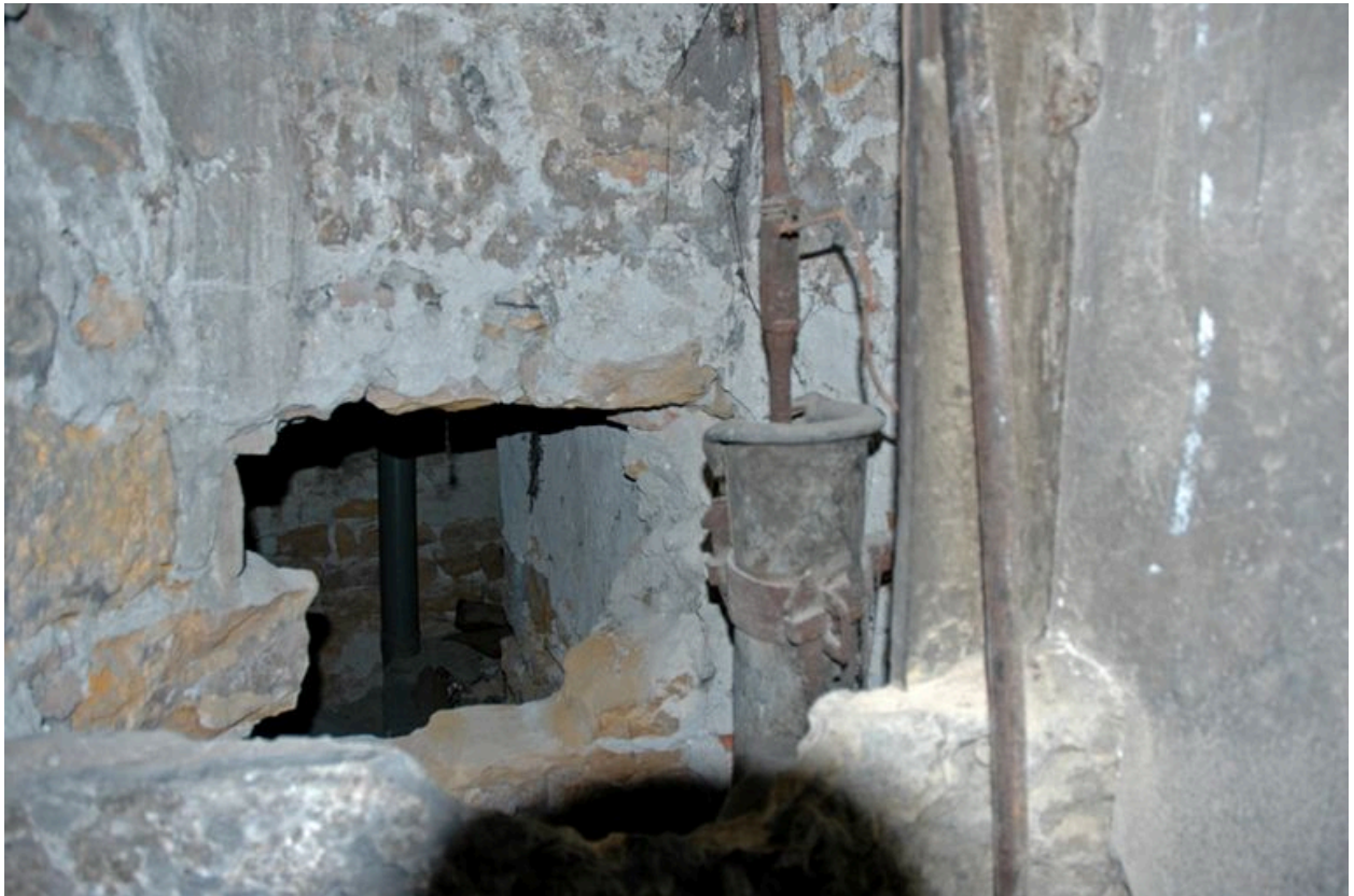
Système à pompe du puits
