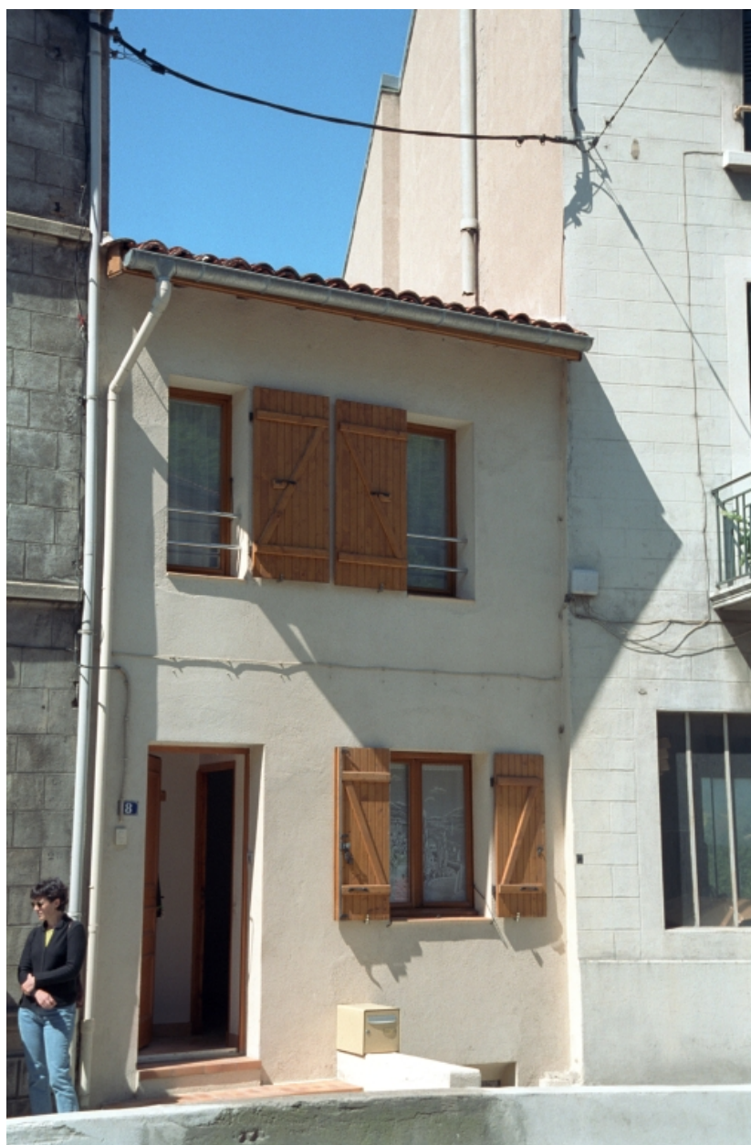
Boën, îlot 12, Clermont(rue de) 8. Vue générale de la façade sur rue.
