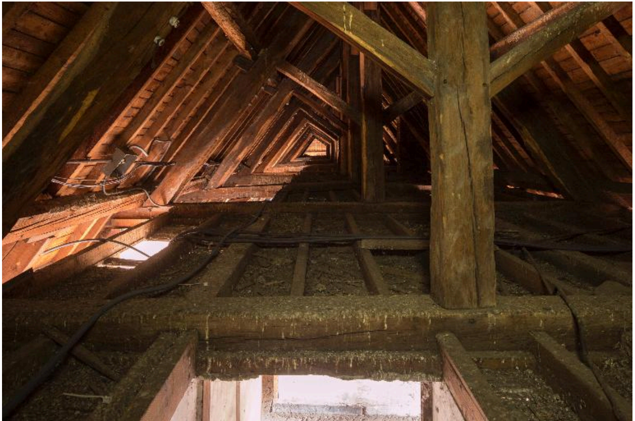
Bâtiment G. Combles
