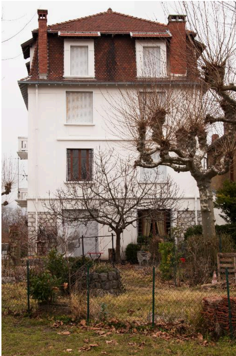
Immeuble Besson : façade sud
