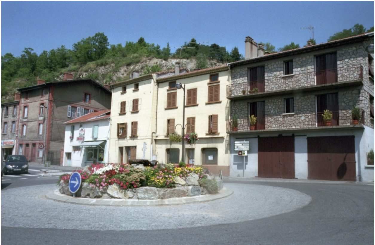
Boën, îlot 17, Lyon (rue de) 99bis et 99 et 97. Vue générale de la façade sur rue.
