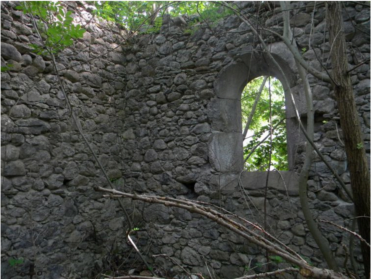
Baie sur le mur gouttereau sud.
