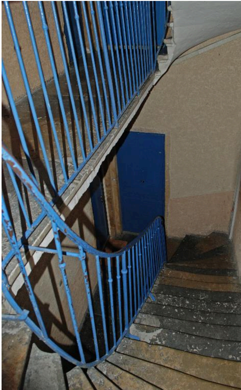
Vue intérieure : la cage d'escalier
