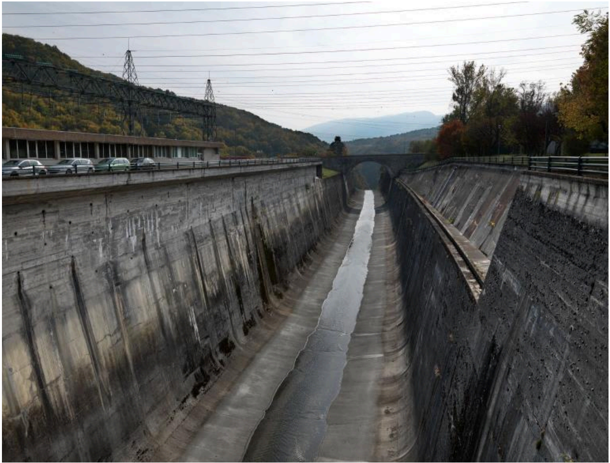
Grand déversoir de crues du barrage de Génissiat
