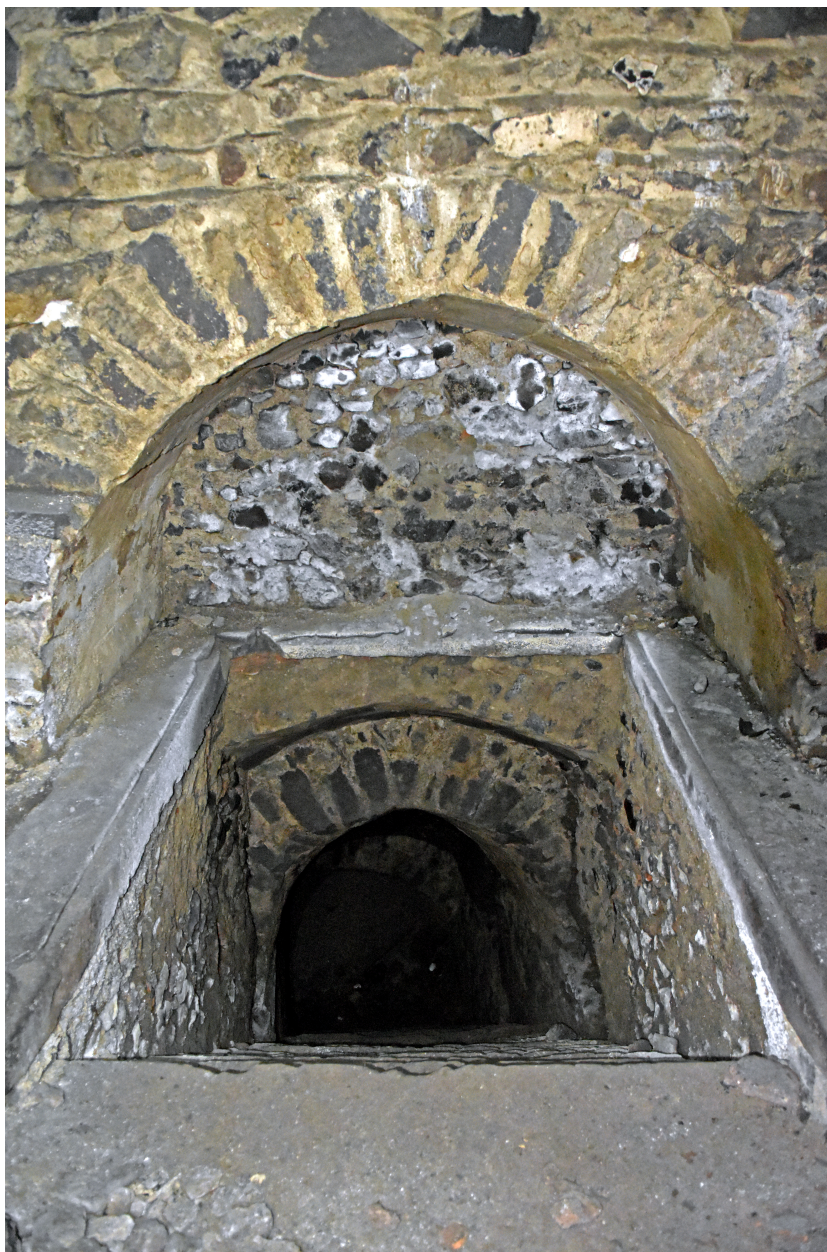
Caves nord, salle n°13 partie est ; escalier descendant vers une cave située au niveau inférieur (non relevée)
