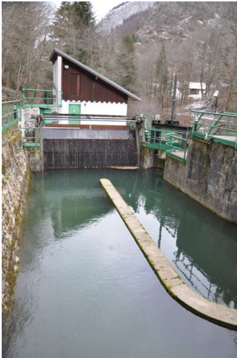
Détail du barrage de retenue
