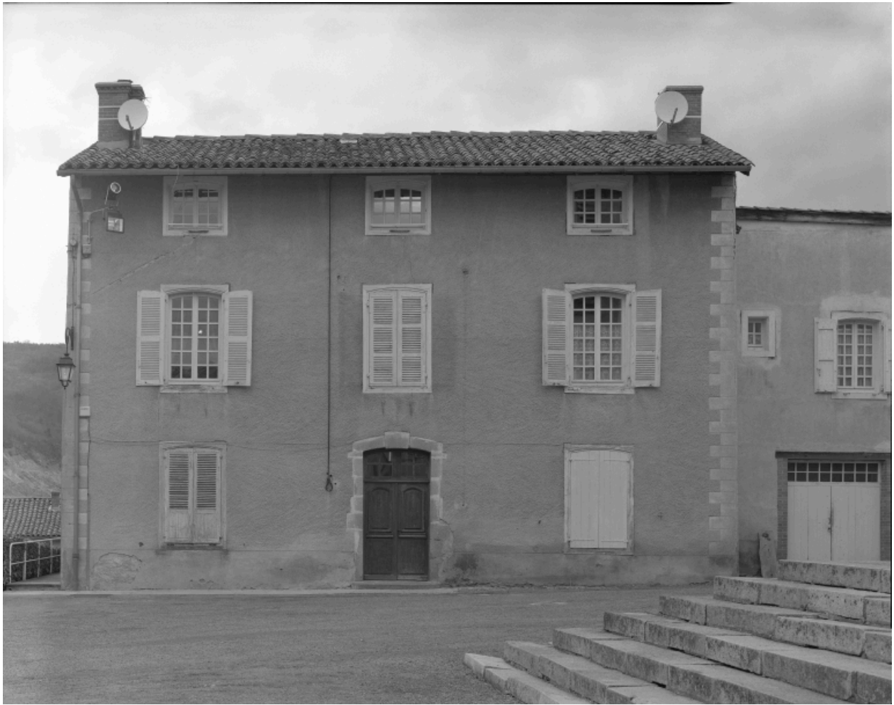
Vue d'ensemble de l'élévation antérieure.
