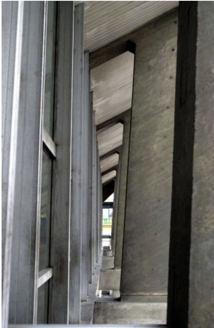
Détail du portique extérieur en béton armé
