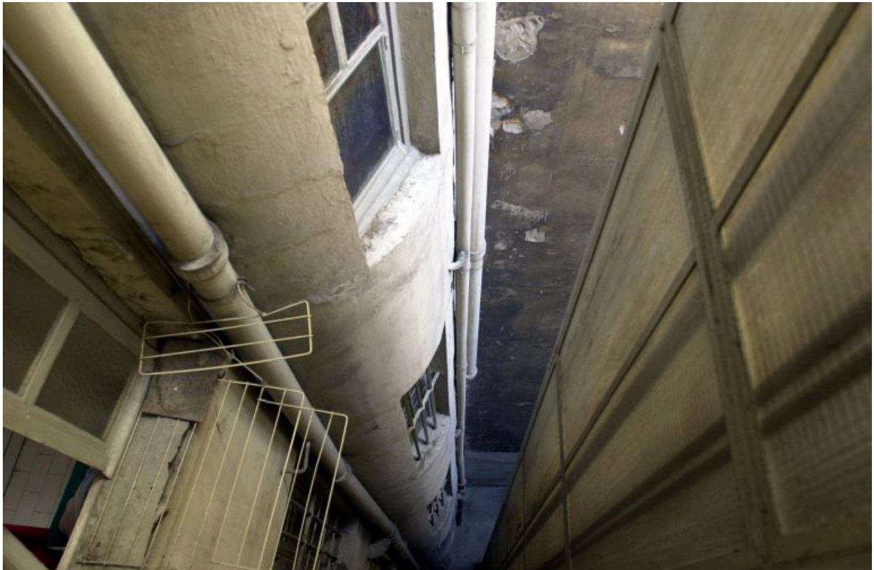
Vue de la cour arrière depuis l'escalier
