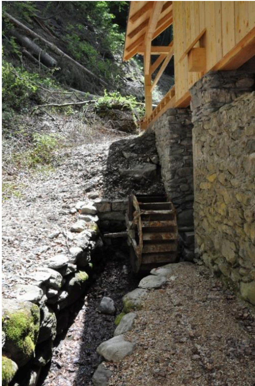
Façade est du bâtiment avec la roue de la scierie et le canal de dérivation.
