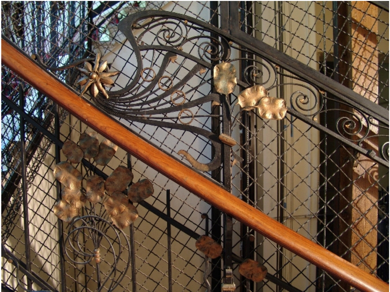
Cage d'ascenseur, détail
