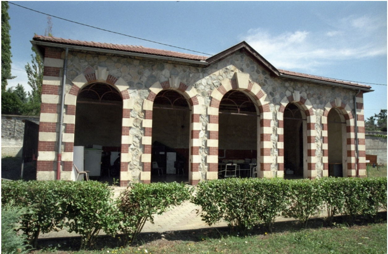
Boën, îlot 15, Voie communale n°14. Vue générale de la façade sur jardin.
