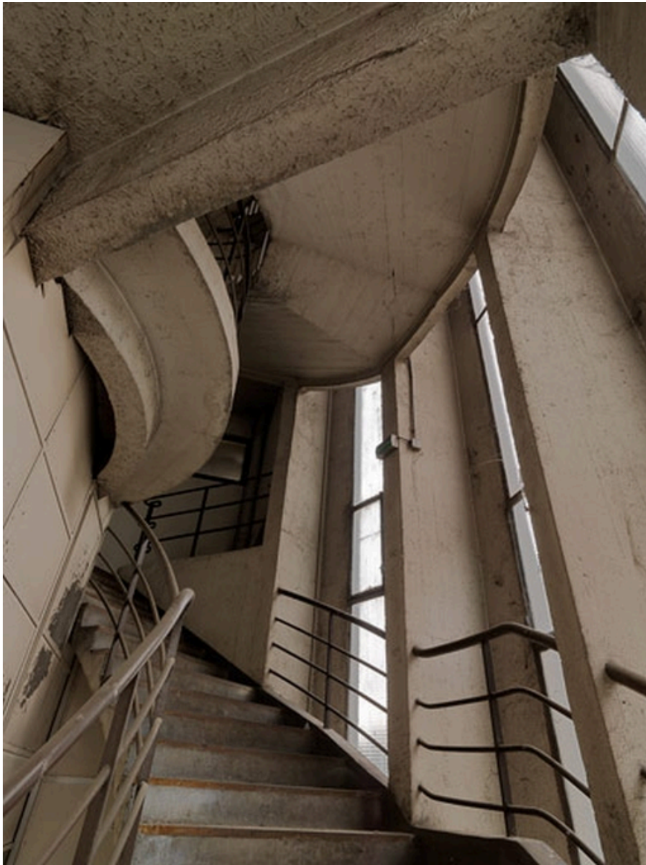
Escalier technique tour sud-est
