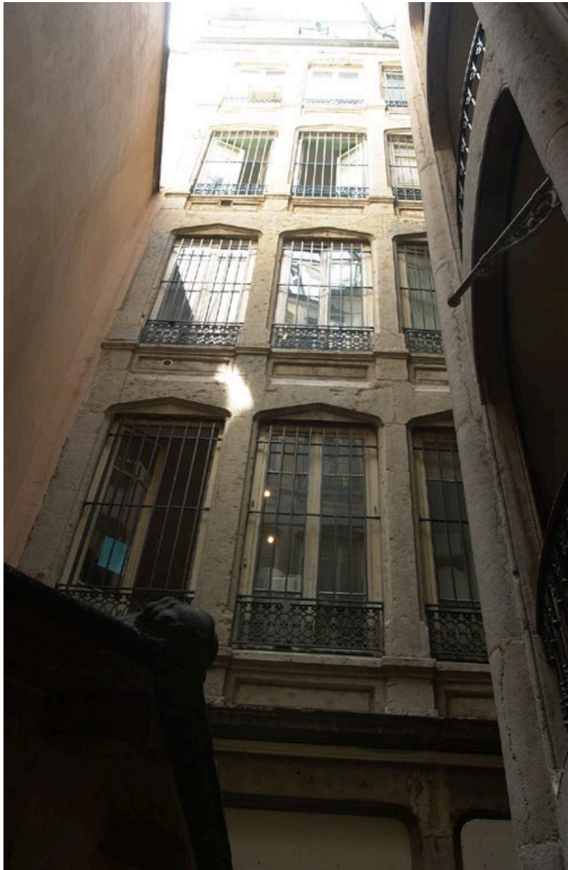
Elévation sur cour du corps de bâtiment est (parcelle AE 135)
