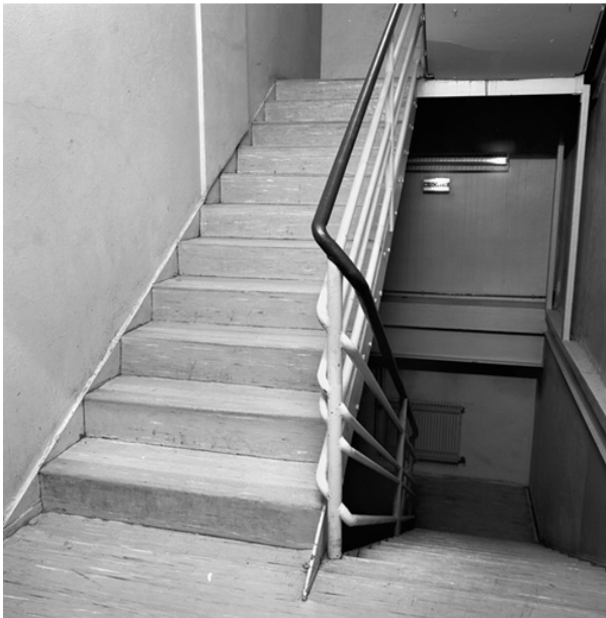
Escalier menant au sous-sol
