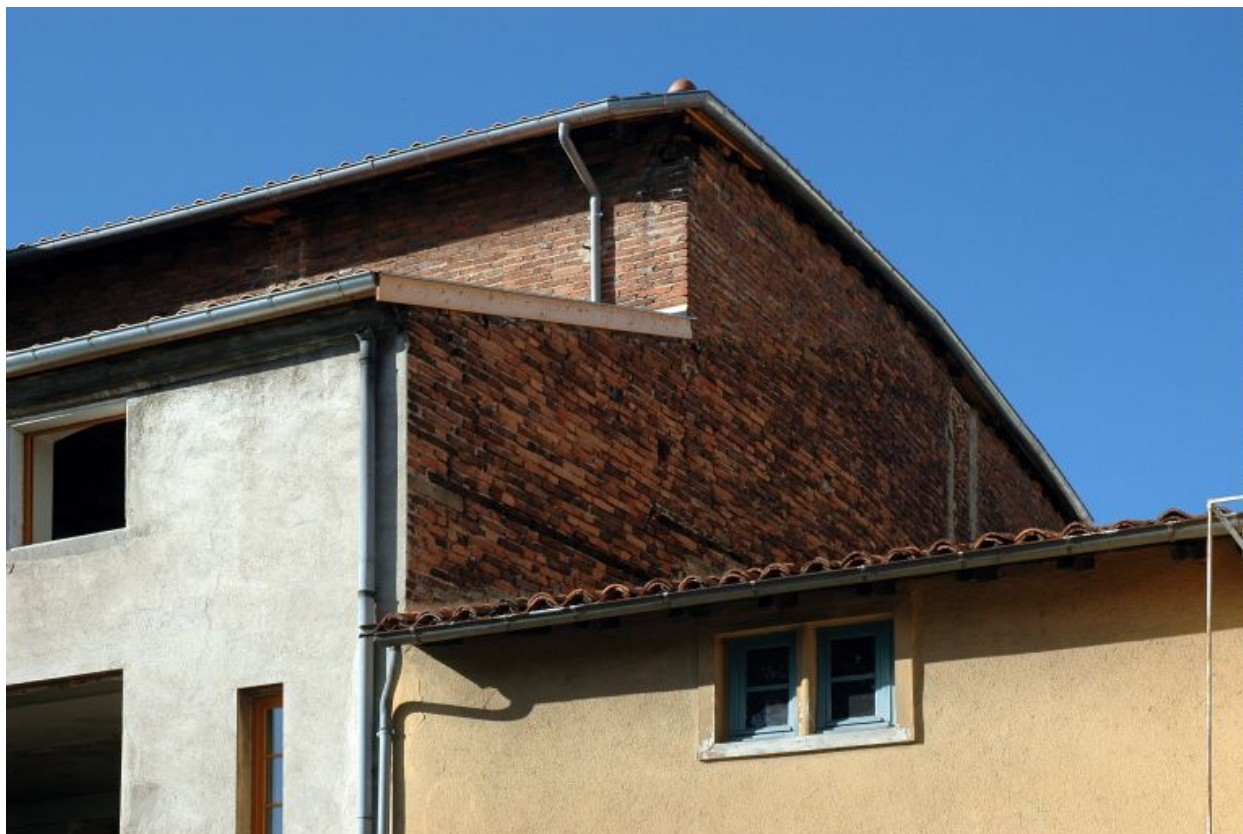
Détail : pignon en brique sur l'élévation postérieure.
