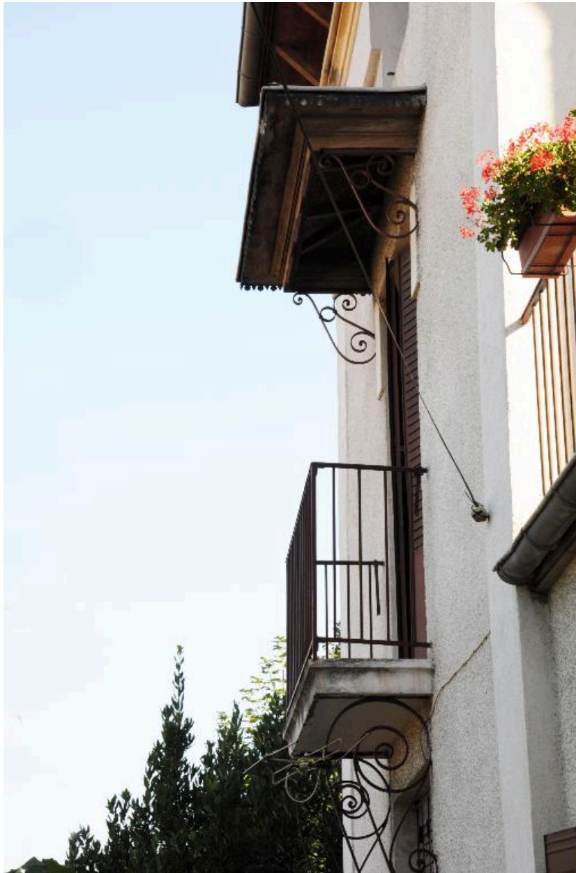
Vestiges du moucharabieh de l'élévation occidentale : balcon et dais à lambrequins
