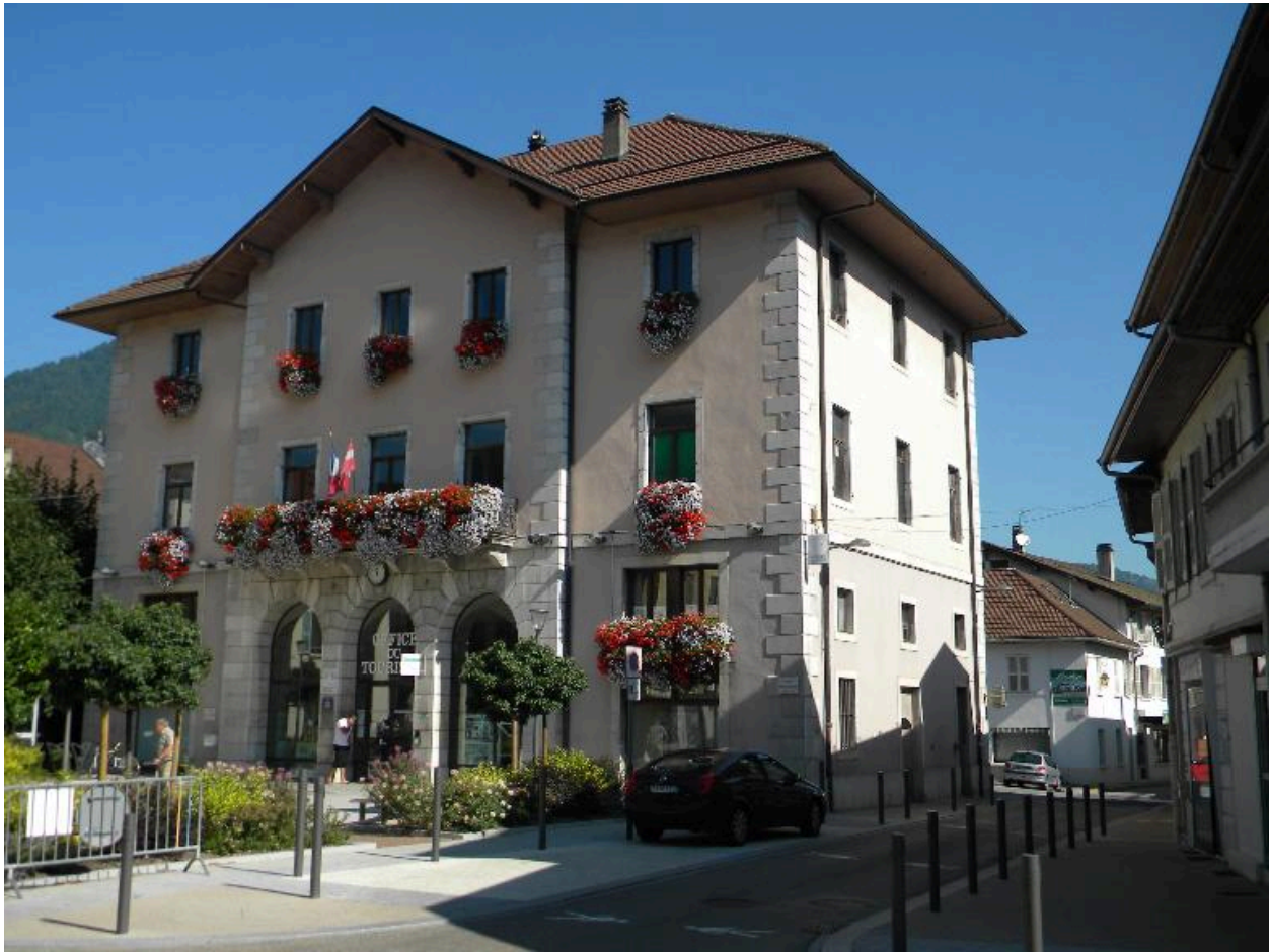
Vue de trois-quarts de la façade principale et la façade sud-est.
