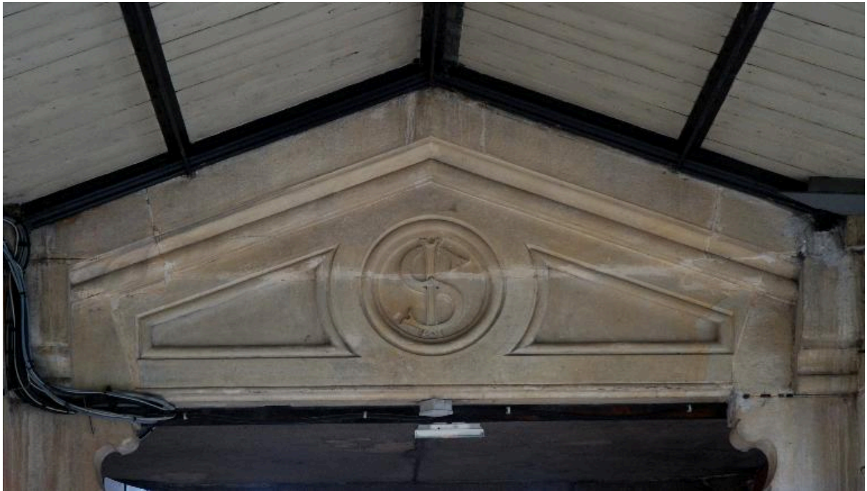
Galerie joignant la porterie au bâtiment principal, détail du fronton
