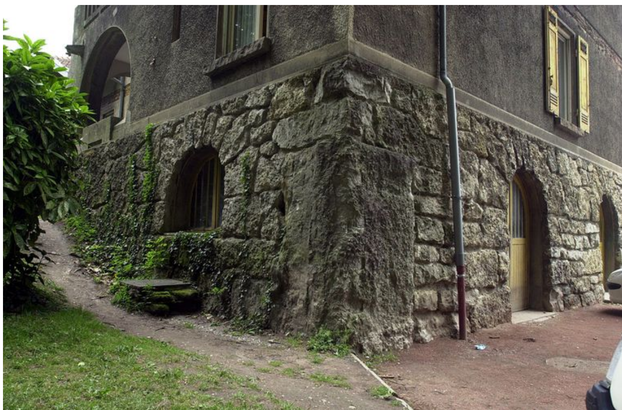
Façade principale, avant-corps de droite, détail du soubassement
