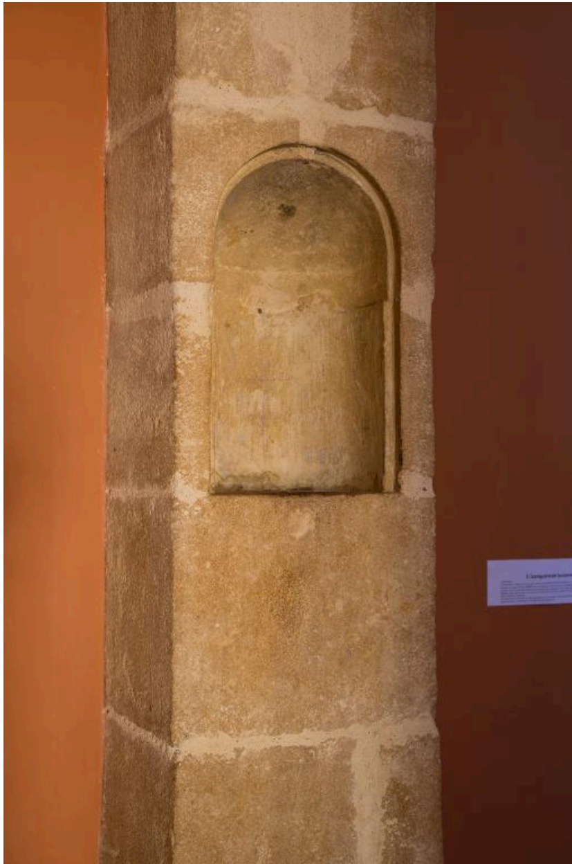
Bâtiment F. Escalier. Détail d'une niche sur le mur central
