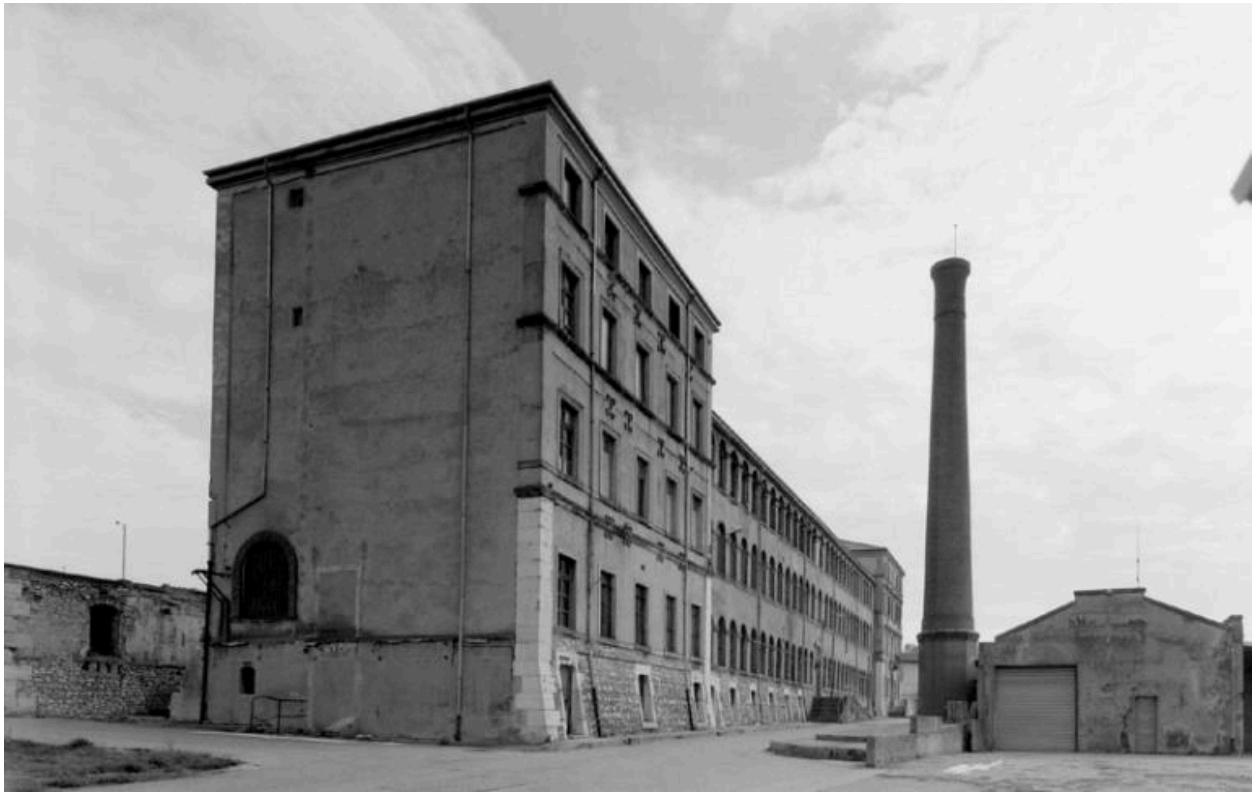
Vue nord du bâtiment principal
