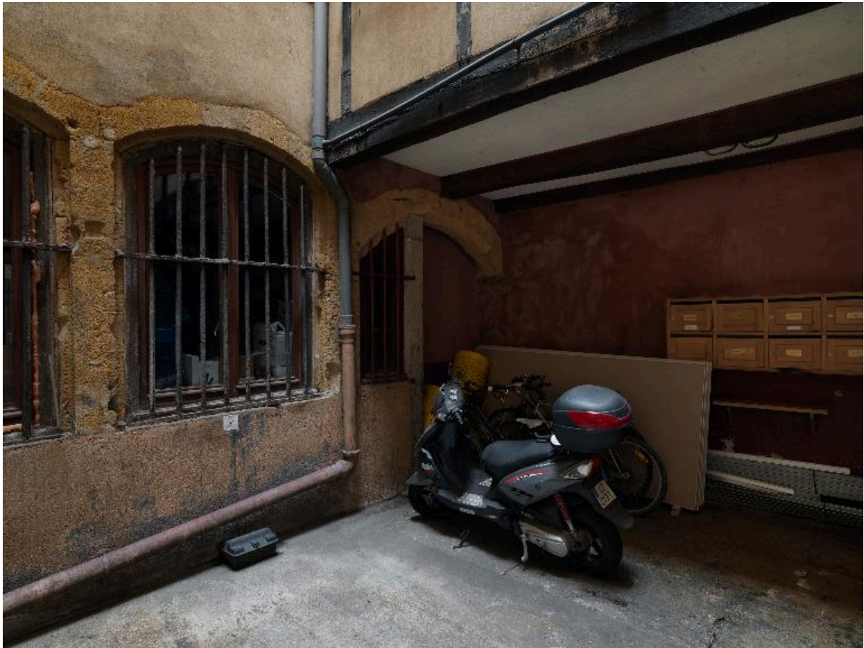
La cour, le prolongement de l'allée et une vue partielle du rez-de-chaussée du corps de bâtiment sur cour
