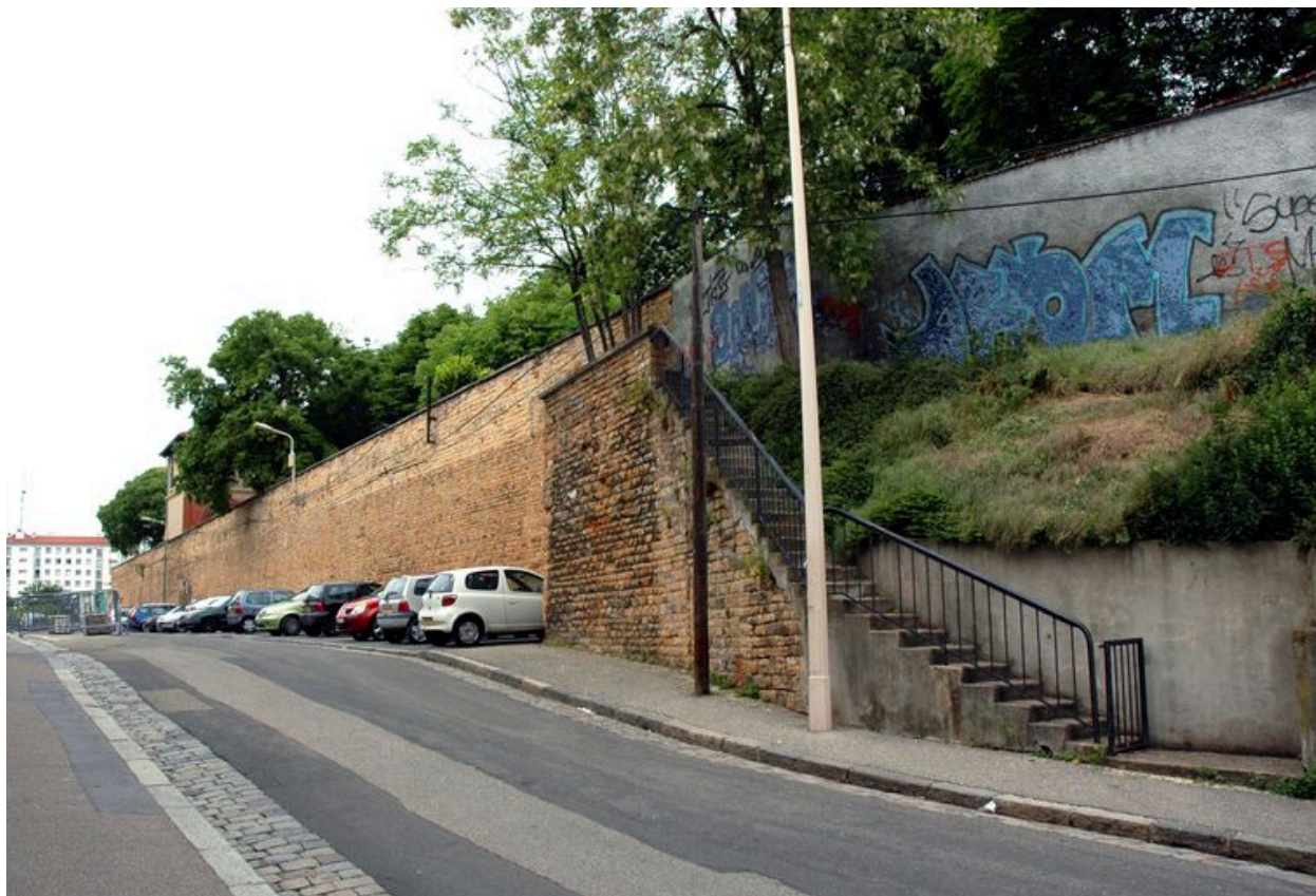
Mur de clôture sud-ouest depuis le sud-est, vue de l'escalier des pavillons du télégraphe
