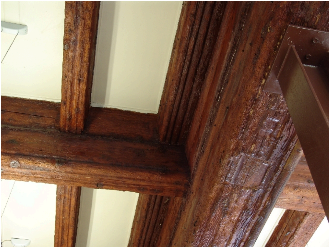
Plafond d'une pièce du rez-de-chaussée, détail
