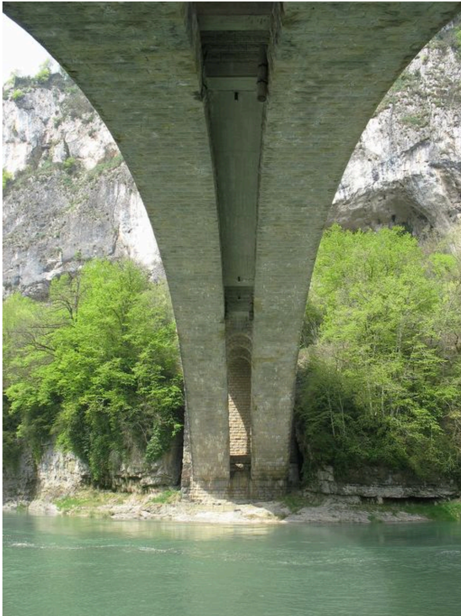
Dessous de l'arche, depuis la rive gauche
