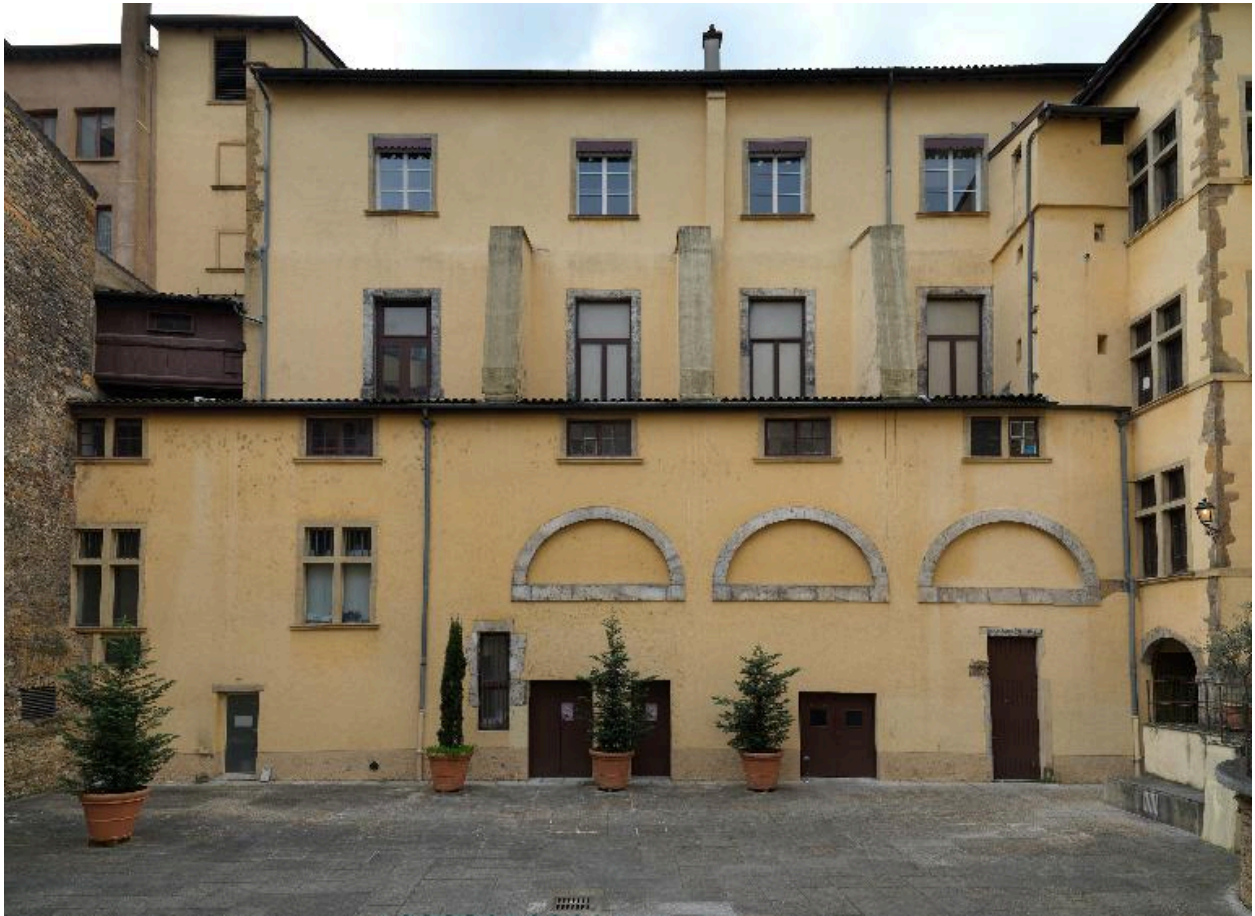
La cour : élévation sud
