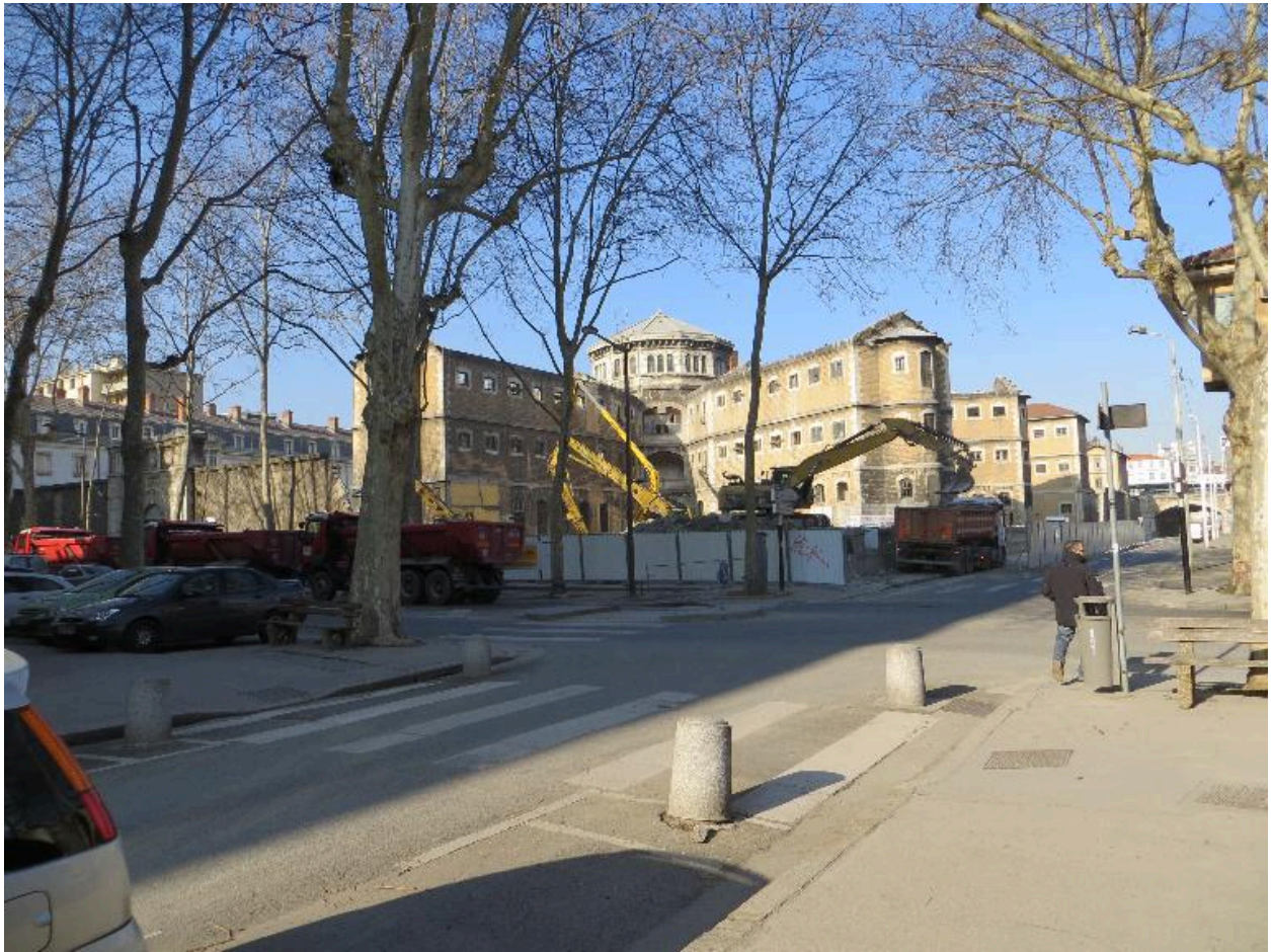
Etat au 19 février 2013 : vue d'ensemble depuis l'angle de la rue Delandine et du cours Suchet
