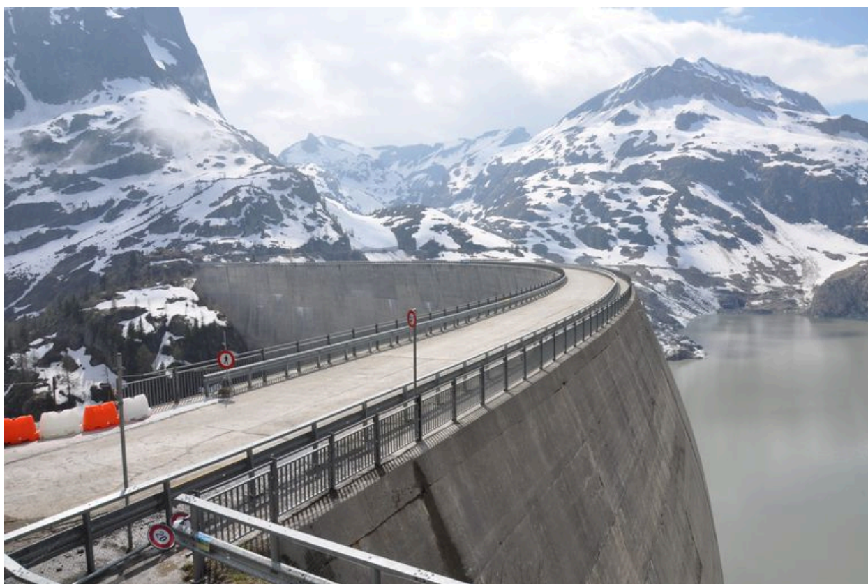
Vue de la crête du barrage voûte
