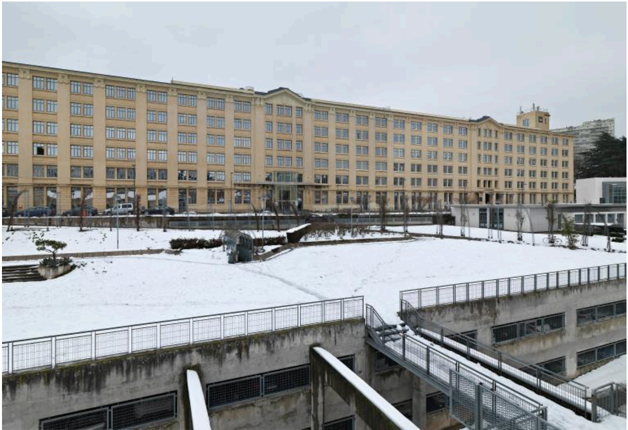
Vue de l'usine à étage
