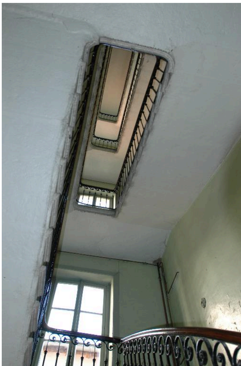
Vue de la cage d'escalier
