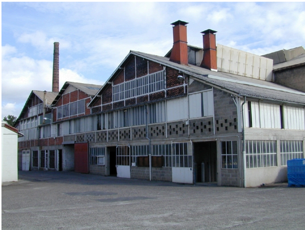
Vue d'ensemble des bâtiments
