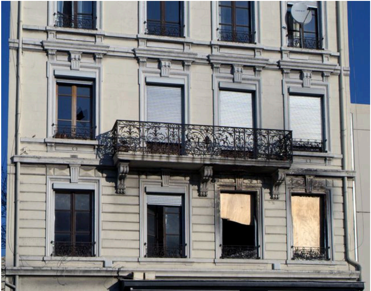
Elévation antérieure, détail
