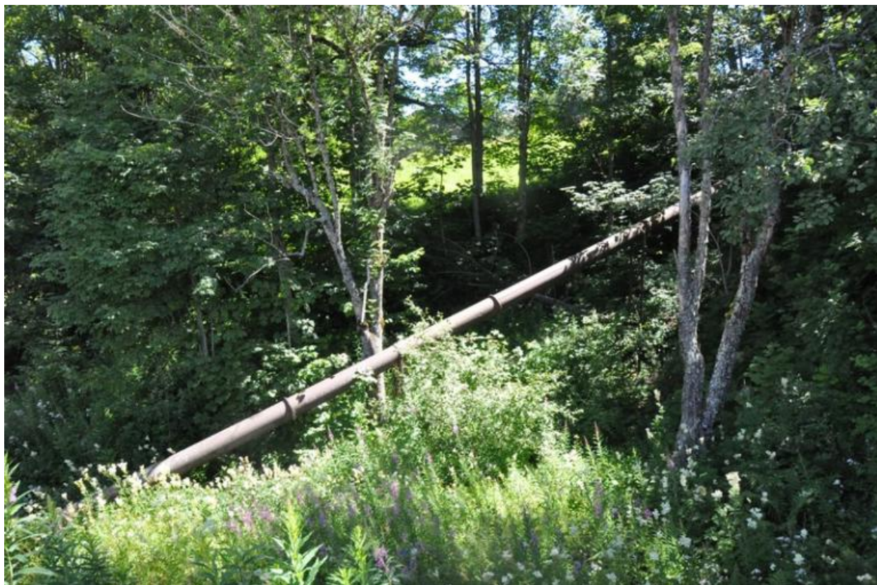
Conduite métallique qui alimentait la scierie.
