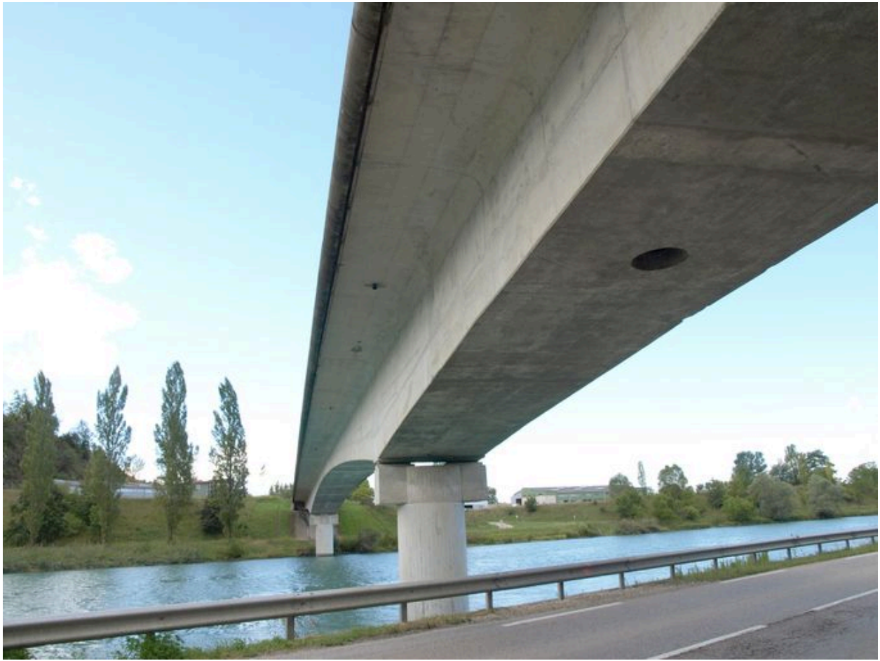
Tablier, vue partielle de dessous, face amont (depuis la rive droite)
