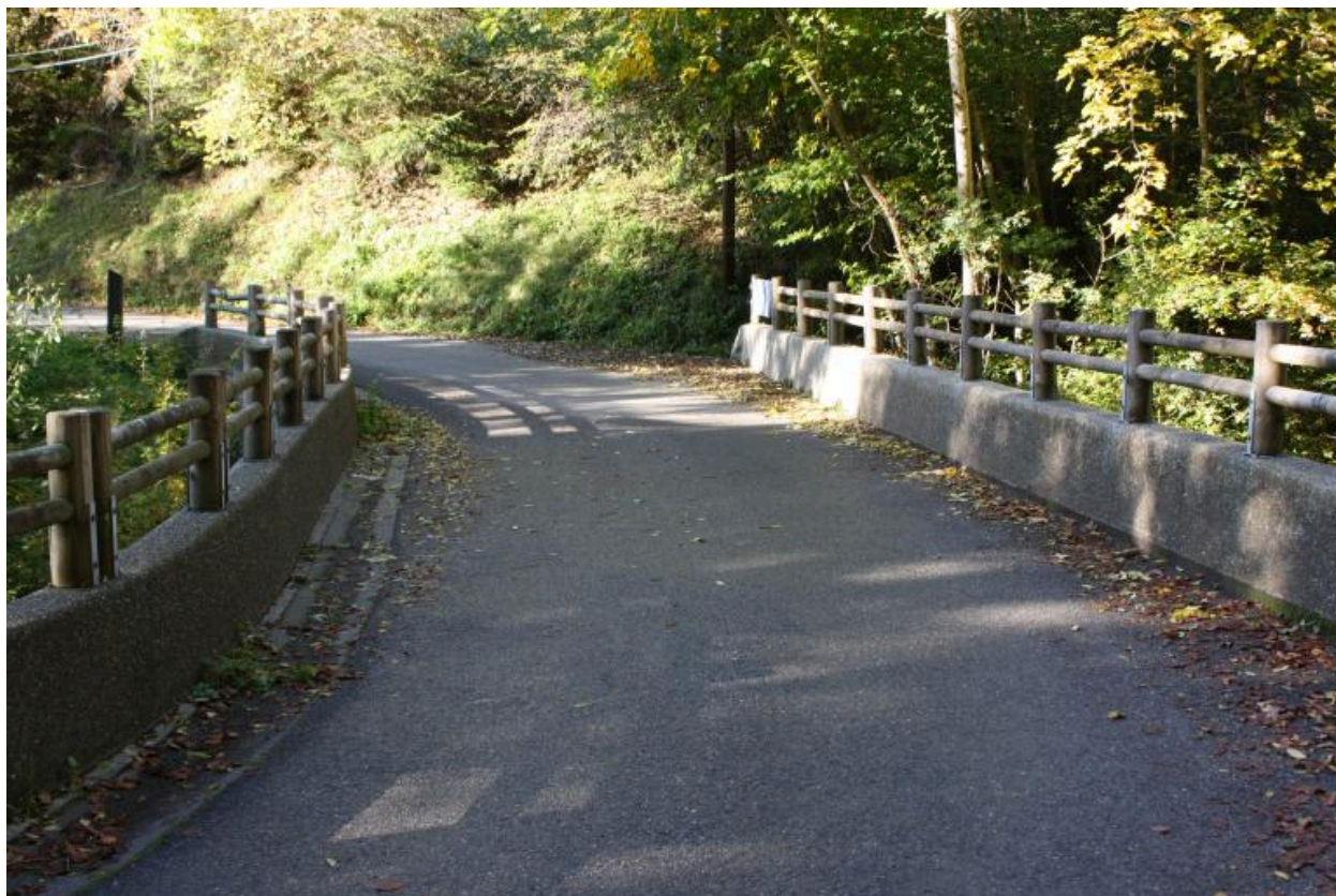
Pont des Onchets, chaussée et gardes corps
