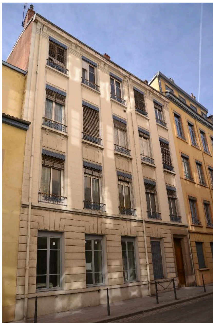
Vue d'ensemble façade nord
